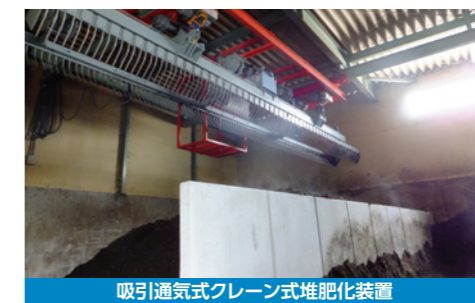
吸引通気式クレーン式堆肥化装置
